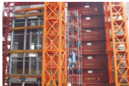
大型建筑幕墙四性检测（10米×16米）
