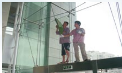
现场检测幕墙拉索内力
