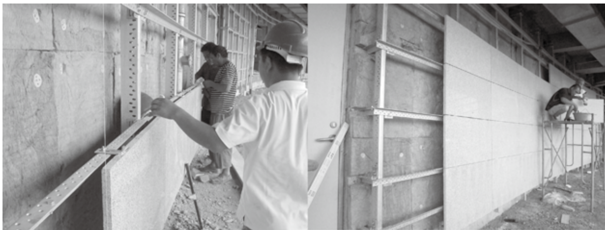
图1 杭州萧山国际机场扩建工程应用（施工现场）
