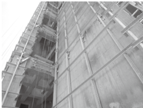
图8 宁波华城花园工程应用（施工现场）
