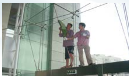
现场检测幕墙拉索内力
