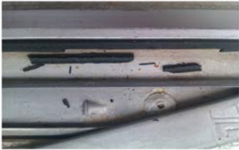
胶两年内就已老化碎裂
