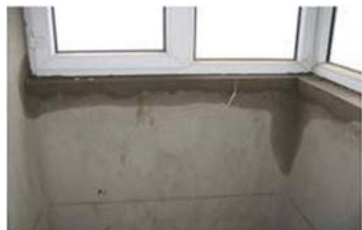
窗边密封失败渗水、漏水
