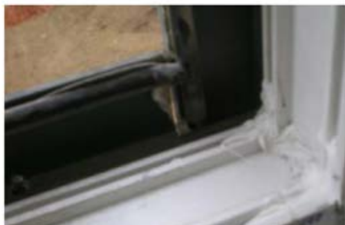
现象：铝塑复合型材匹配，导致铝材胀开
