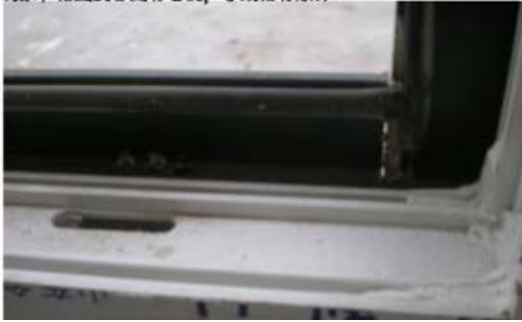
现象：铝塑复合型材匹配，导致铝材胀开
