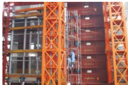
大型建筑幕墙四性检测（10米×16米）
